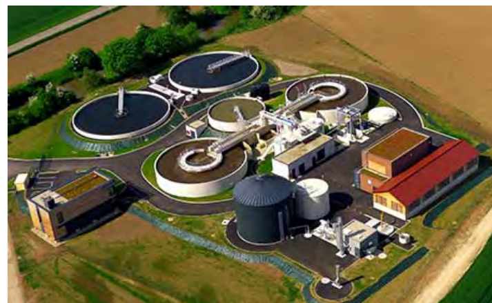
Station d'épuration de Weyersheim vue du ciel, ©SDEA
